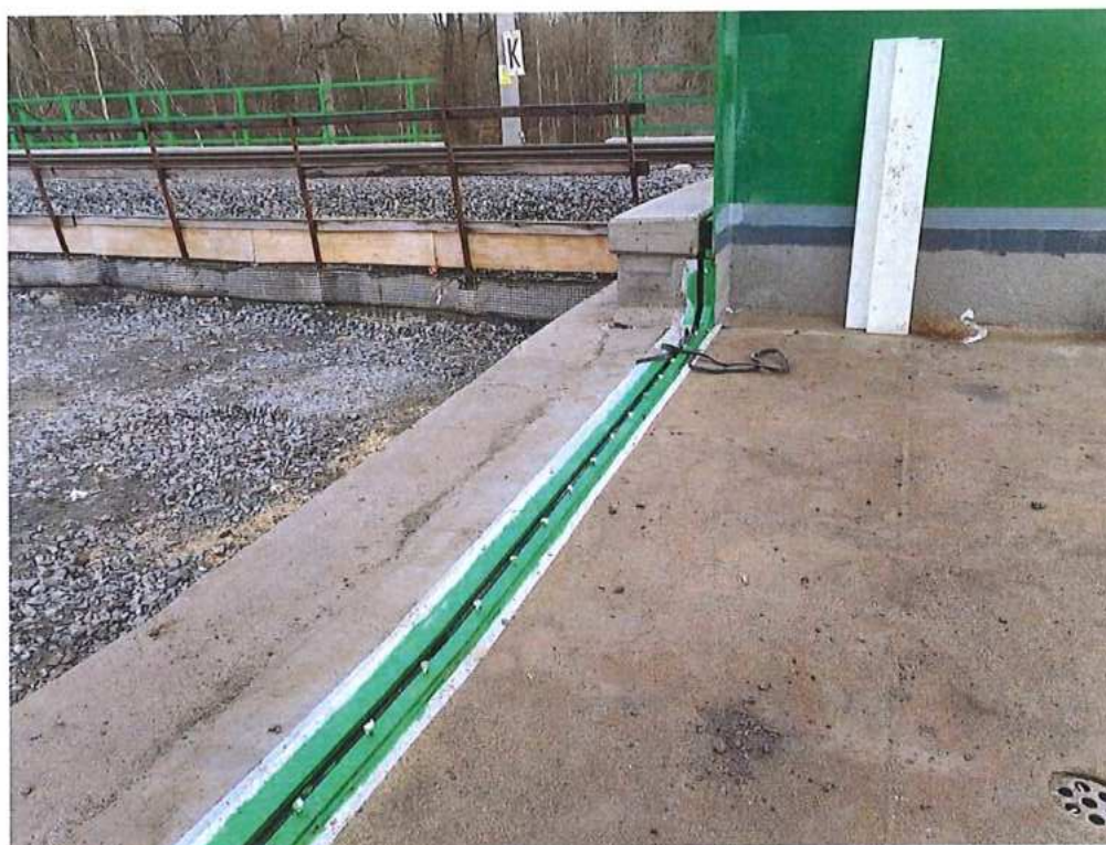
Betonáž MZ a rímsy CZ strana - SO 12-33-04
