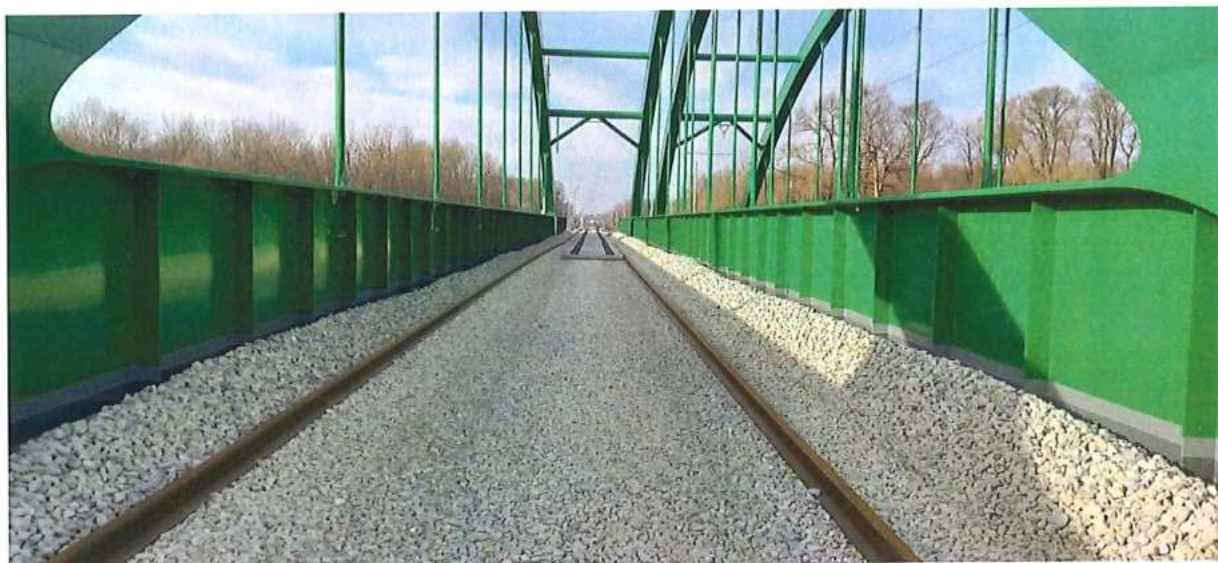
Predštrkovanie a pokládka podvalov – SO 12-32-01
