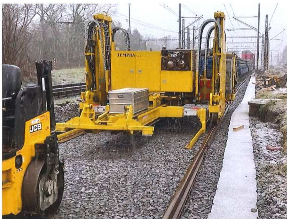
Pokládka podvalov a koľajníc - SO 10-32-01
