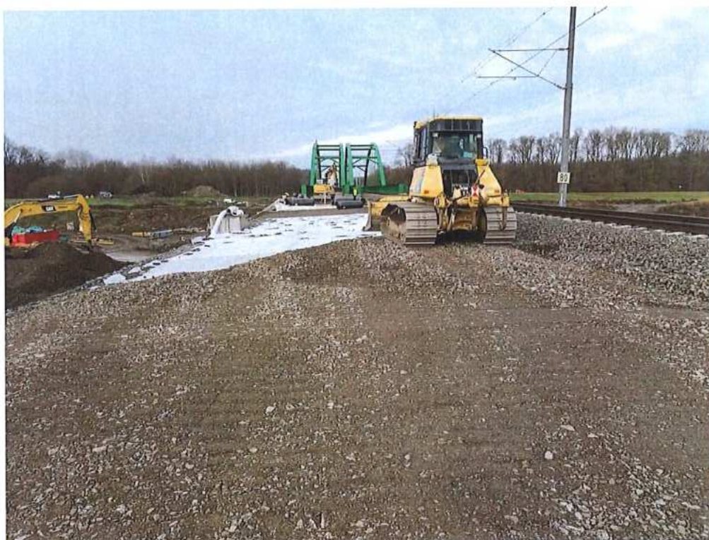
Pokládka geodrénu a zriadenie PŽS - SO 12-32-02
